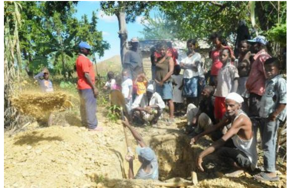
Figure 6. Voisins s'entraîdant dans la fouille de fosses en préparation à la construction de leurs propres latrines
